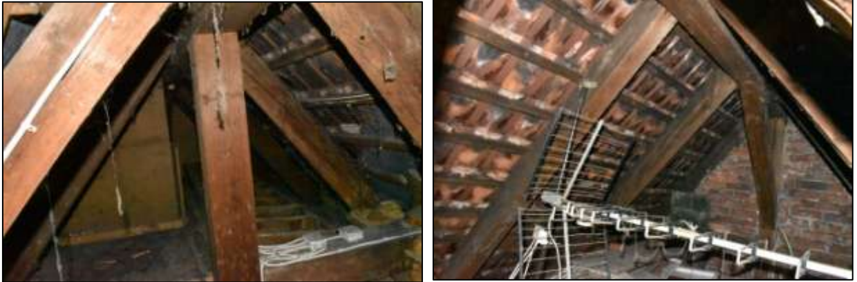
Abbildungen: Dachboden, soweit zugänglich
