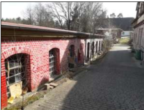
Abbildungen: Ansicht Eingang
